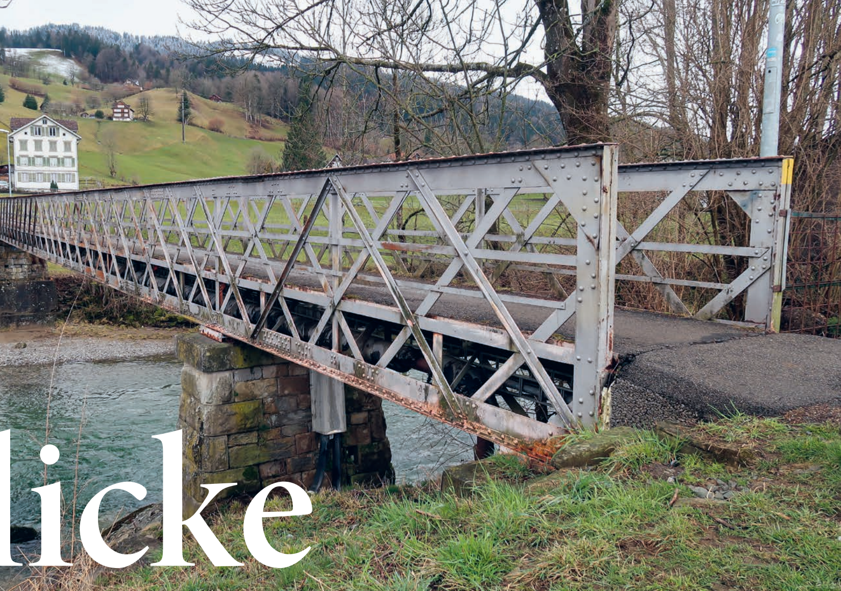
Der Schwarze Steg in Ebnet-Kappel vor der Restaurierung 2023.
